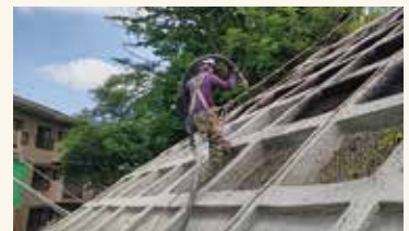
法面での吹付作業の様子
